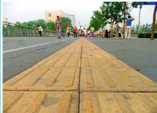
Şekil 52 – Kaldırırda hissedilebilir yüzeylerle yönlendirme örnekleri
